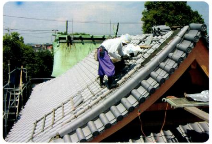
屋根瓦施工(6月)
