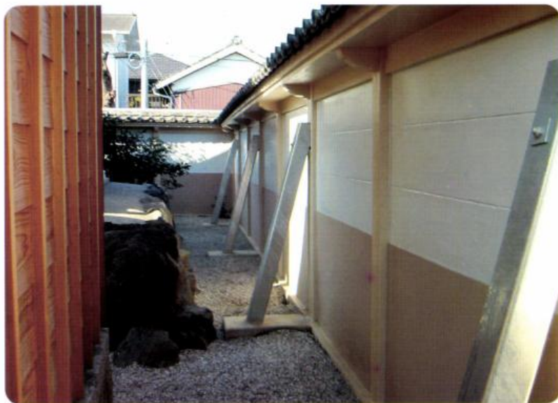
本殿裏の塀塗装完、砂利敷く(12月)
