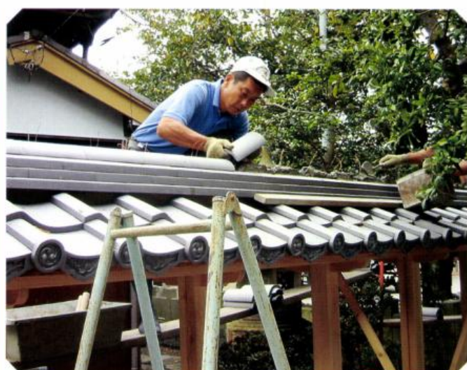
中垣囲い塀の屋根瓦施工
