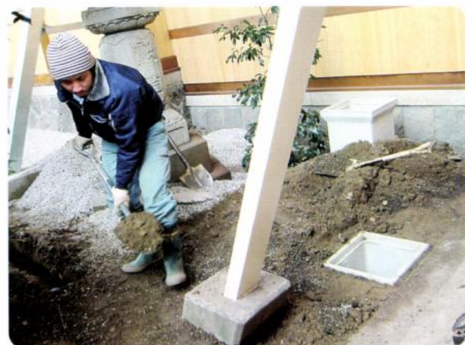
排水工事「斎文殿西」(2月)
