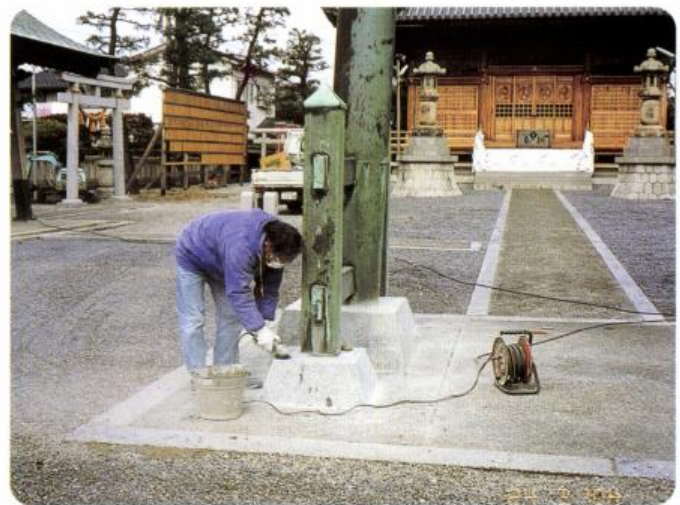
正面鳥居基礎磨き出し(1月)
