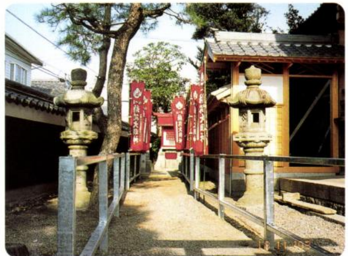
稲荷社幟立て工事(11月)
