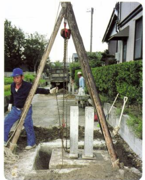
石わく修復工事(8月)
