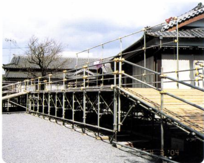
櫓を設置中(3月)
