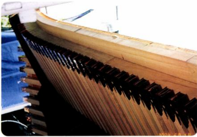
軒先工事完成(6月)
