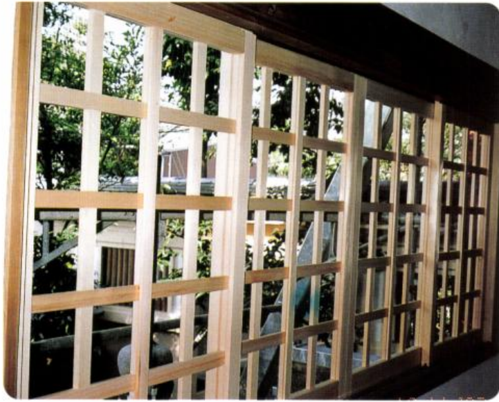
ガラス窓工事(11月)
