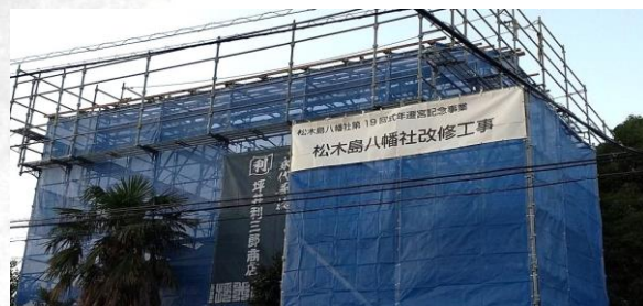
10月には、仮設の屋根で覆われました
