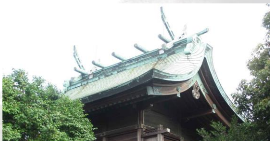
昨年9月の工事着手前の状況
