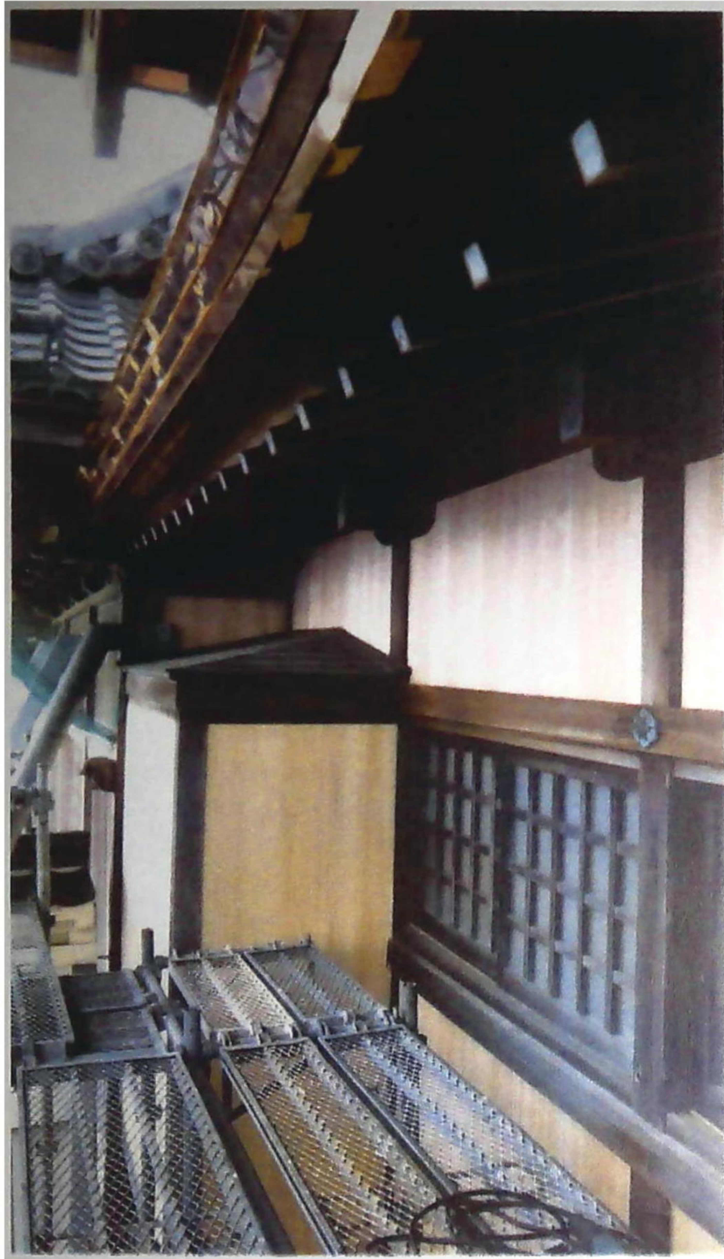
①本殿囲い修繕
