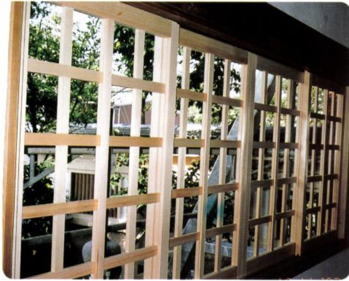
ガラス窓工事(11月)
