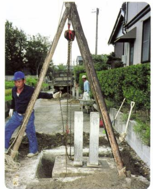
石わく修復工事(8月)
