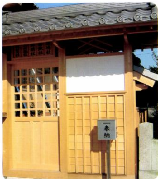
中垣囲い塀、門完成(12月)
