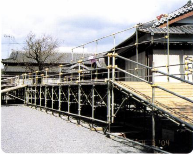
檜を設置中(3月)
