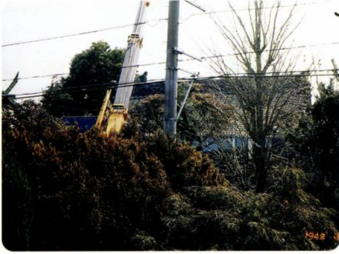
旧屋根瓦撤去 (3月)
