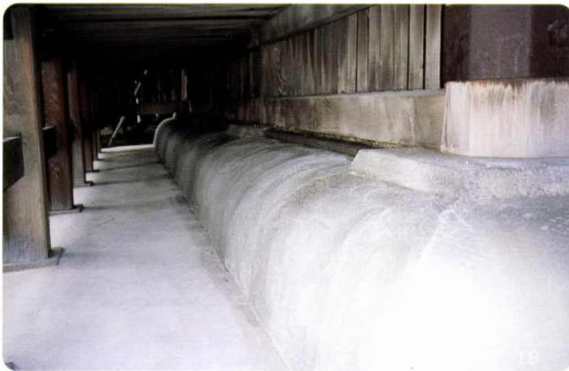
拝殿亀腹工事(7月)
