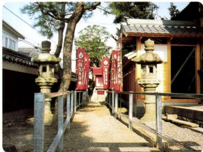
稲荷社幟立て工事(11月)
