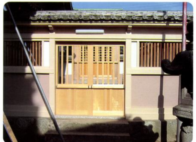
末社入口門塗装完、扉取付け(12月)
