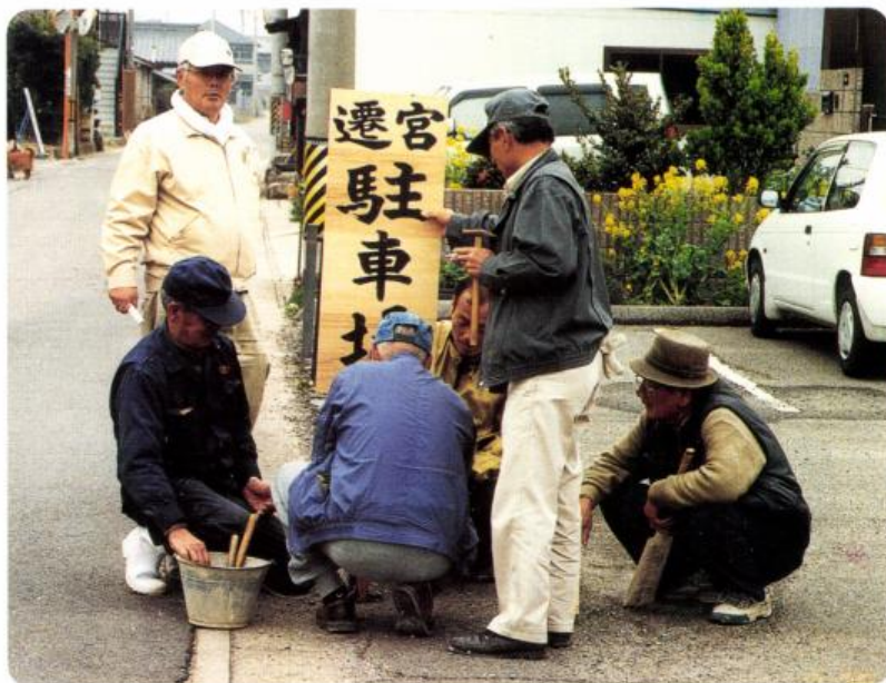
駐車場の案内板設置中
