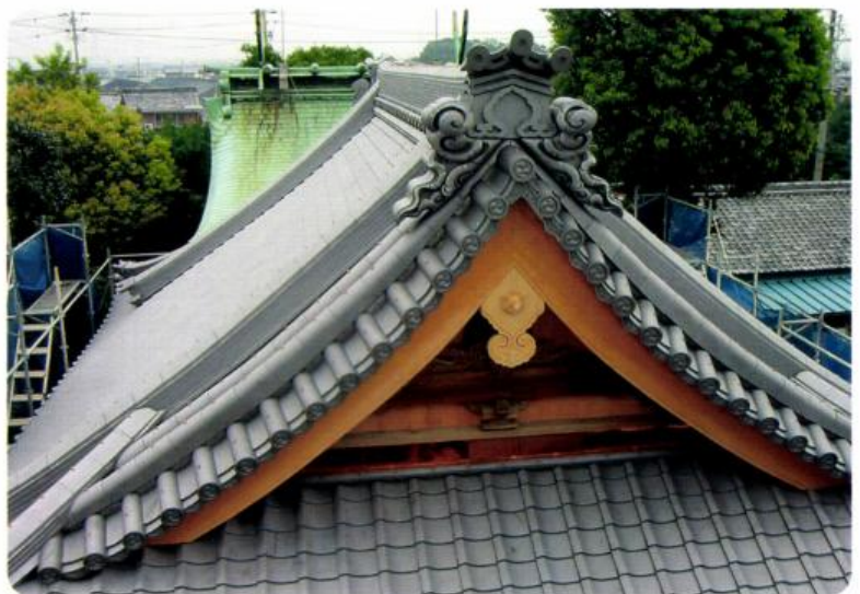
屋根工事完成 (8月)
