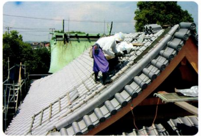
屋根瓦施工 (6月)
