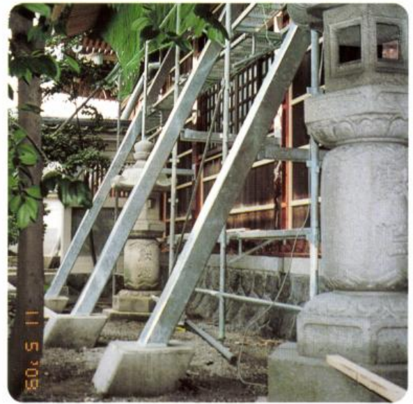
柱補強基礎工事(11月)
