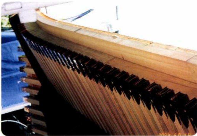
軒先工事完成 (6月)
