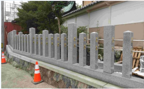
神社北通りで進められる玉垣工事
